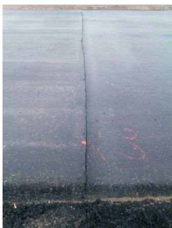
Рис. 1. Поперечні низькотемпературні тріщини: а) вузькі нерегулярні тріщини між технологічними швами, б) прямі широкі тріщини на технологічних швах
